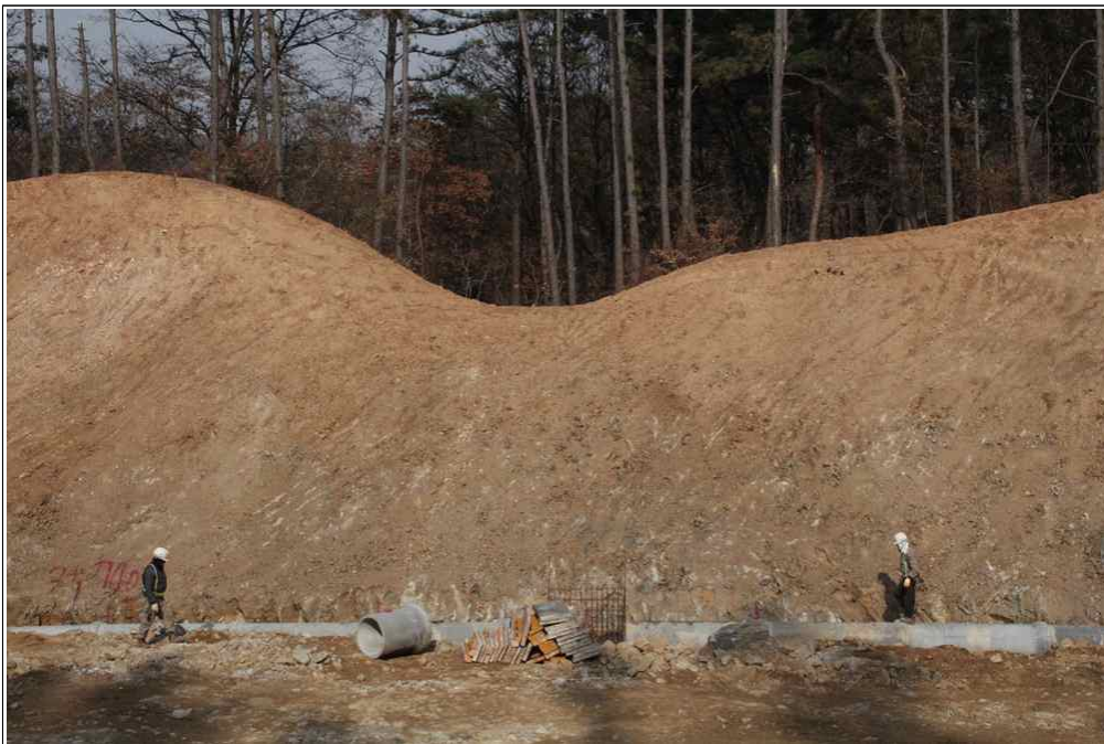
【그림 13】 A 영역 계곡부 전경사진 (STA.3+750)
