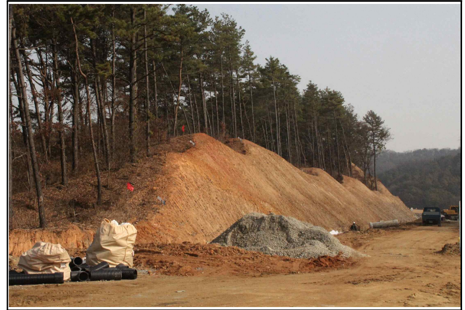
【그림 4】 깎기비탈면 종점부 측면 사진
