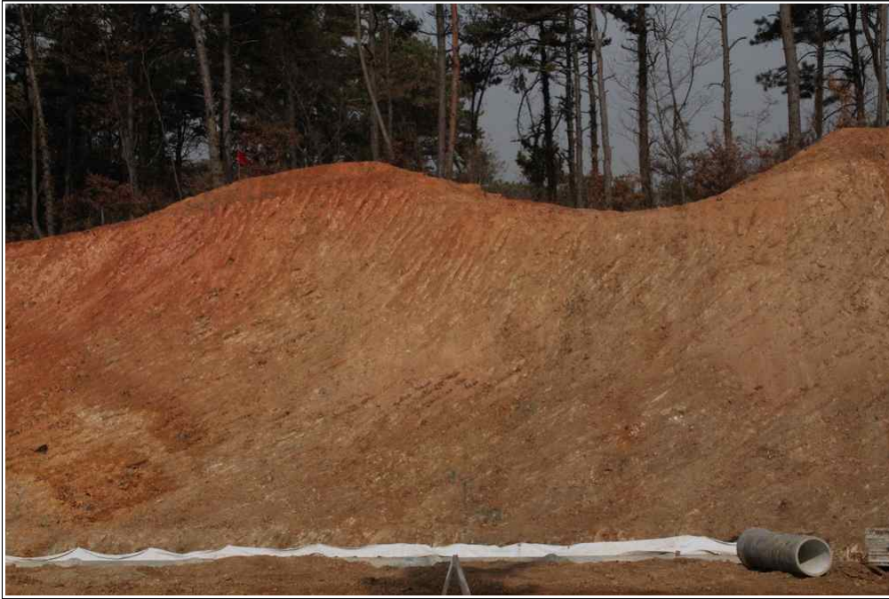
【그림 5】 상부자연비탈면 (계곡부 STA.3+690)
